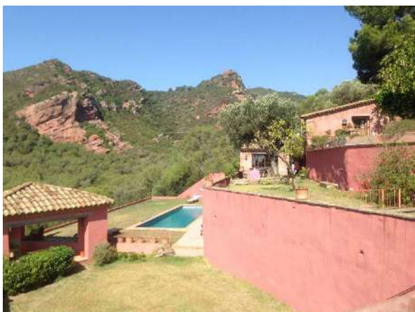
Vista de l'Edificació Auxiliar 03 (mirador) i de la 04
