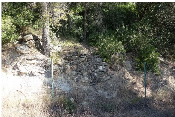
Foto 9. Marge de pedra seca d'una antiga feixa de conreu que actualment està colonitzada per bosc.
