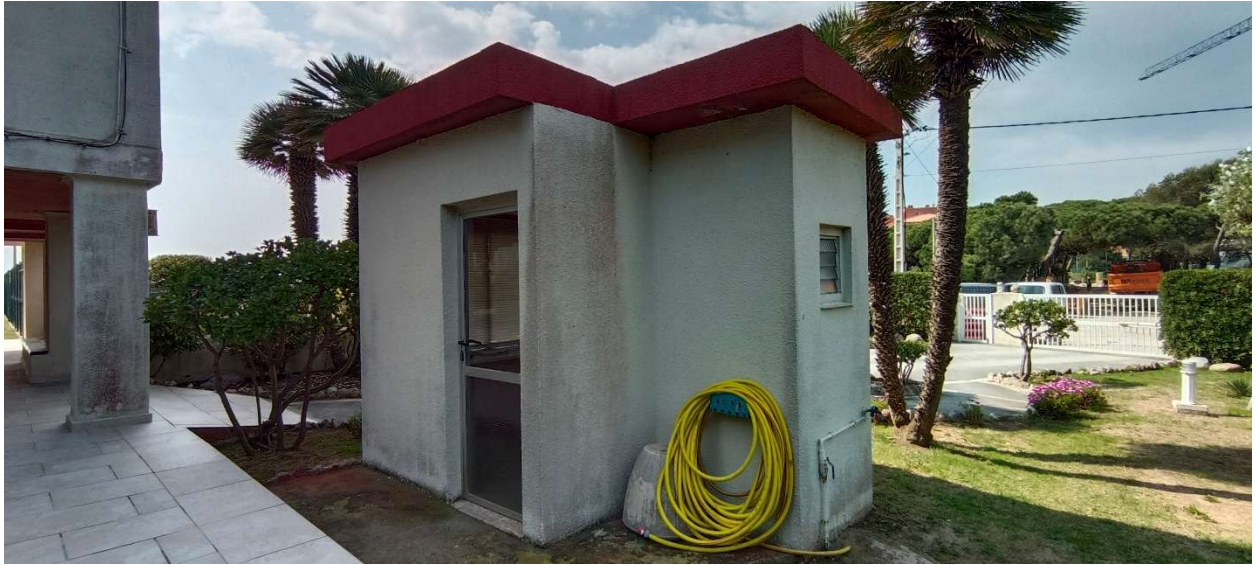
CASETA DE CONTROL
