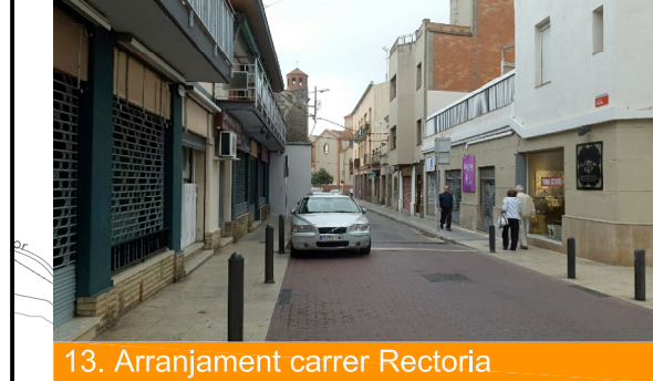
13. Arranjament carrer Rectoria
