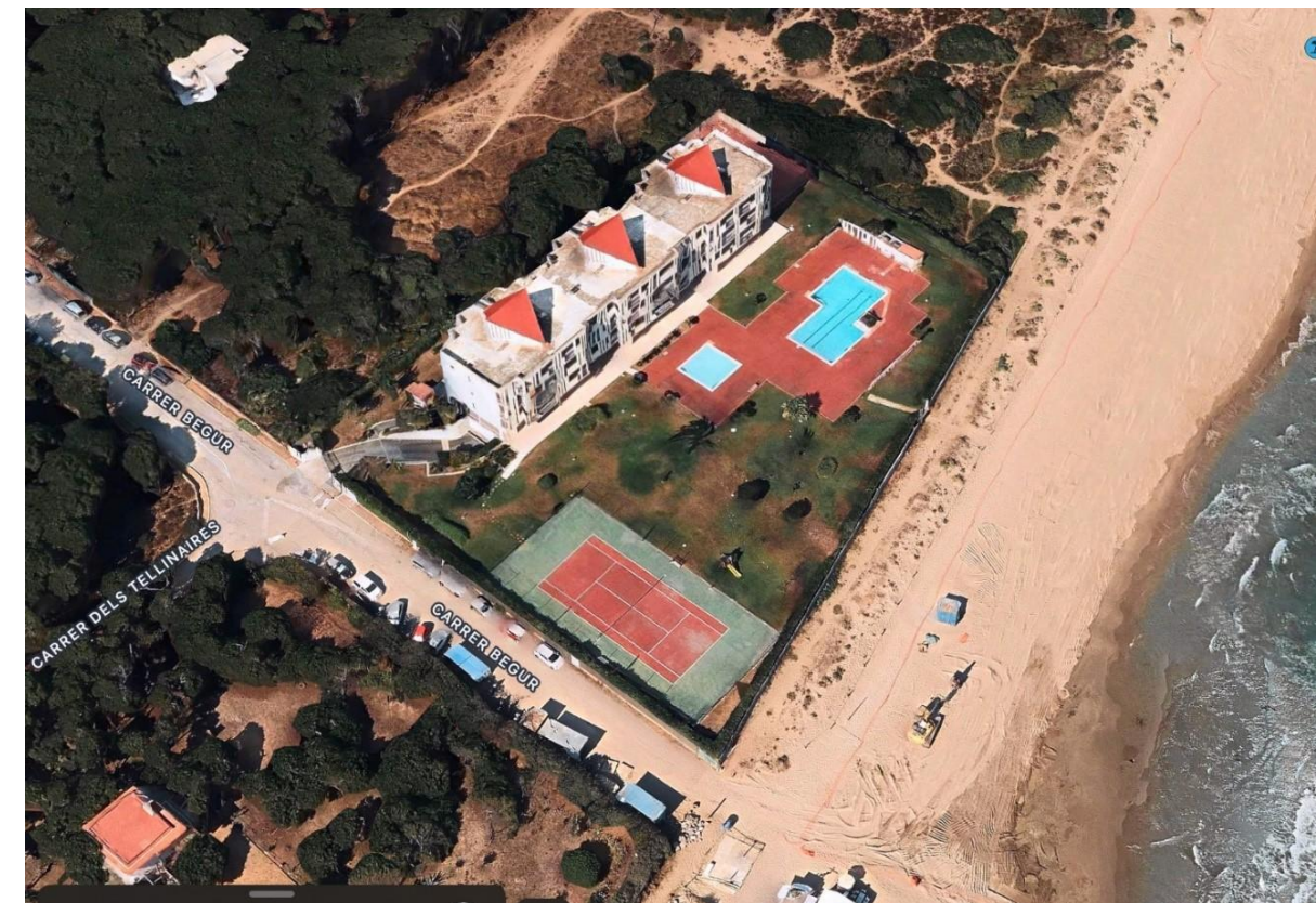
Edificació Apartaments Ibiza existent, amb terrasses de grans dimensions a la façana sud
