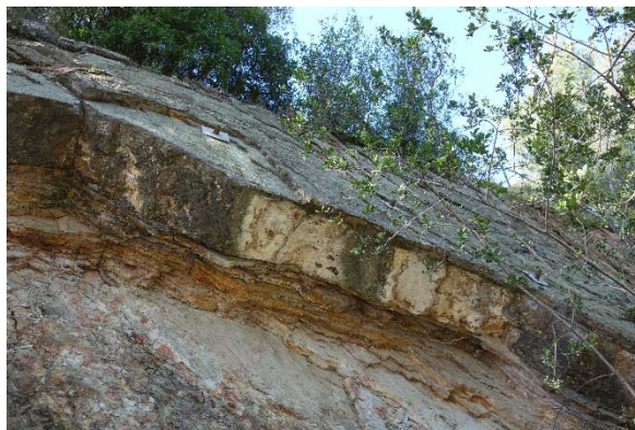
Foto 6. Detall d'un dels bancs de calcàries que ha estat necessari fixar per evitar els lliscaments.
